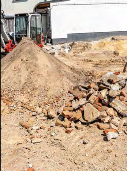
Ausgesiebtetes Material auf einer Baustelle
