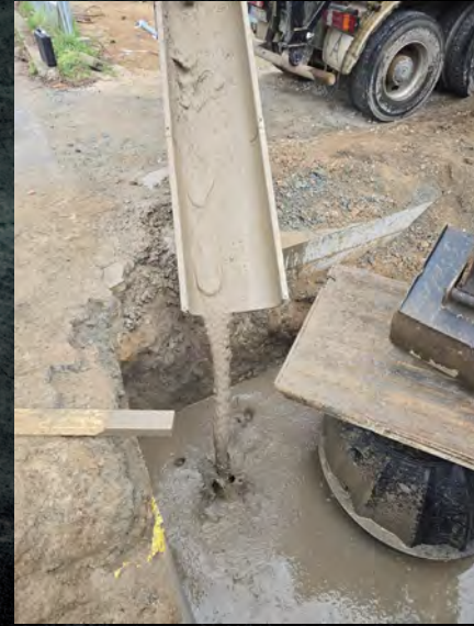
Eingebrachter Flüssigboden
