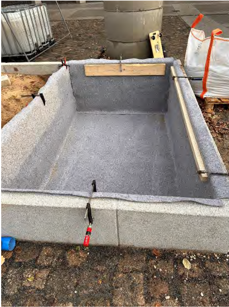
Vlies zum Schutz der Folie außen
