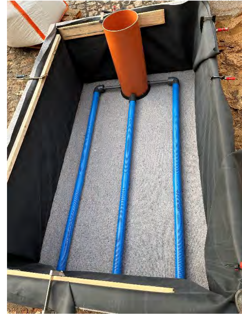
Horizontaldrän DN 80 SW 2 mm
