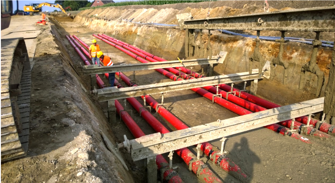
Auf der D.A.CH-Tagung in Dresden werden Zukunftsfragen in den Mittelpunkt gerückt – so z. B. der Einsatz von Flüssigboden bei der Erdkabelverlegung im Zuge des Netzausbaus in Deutschland. Foto: RAL GG Flüssigboden
