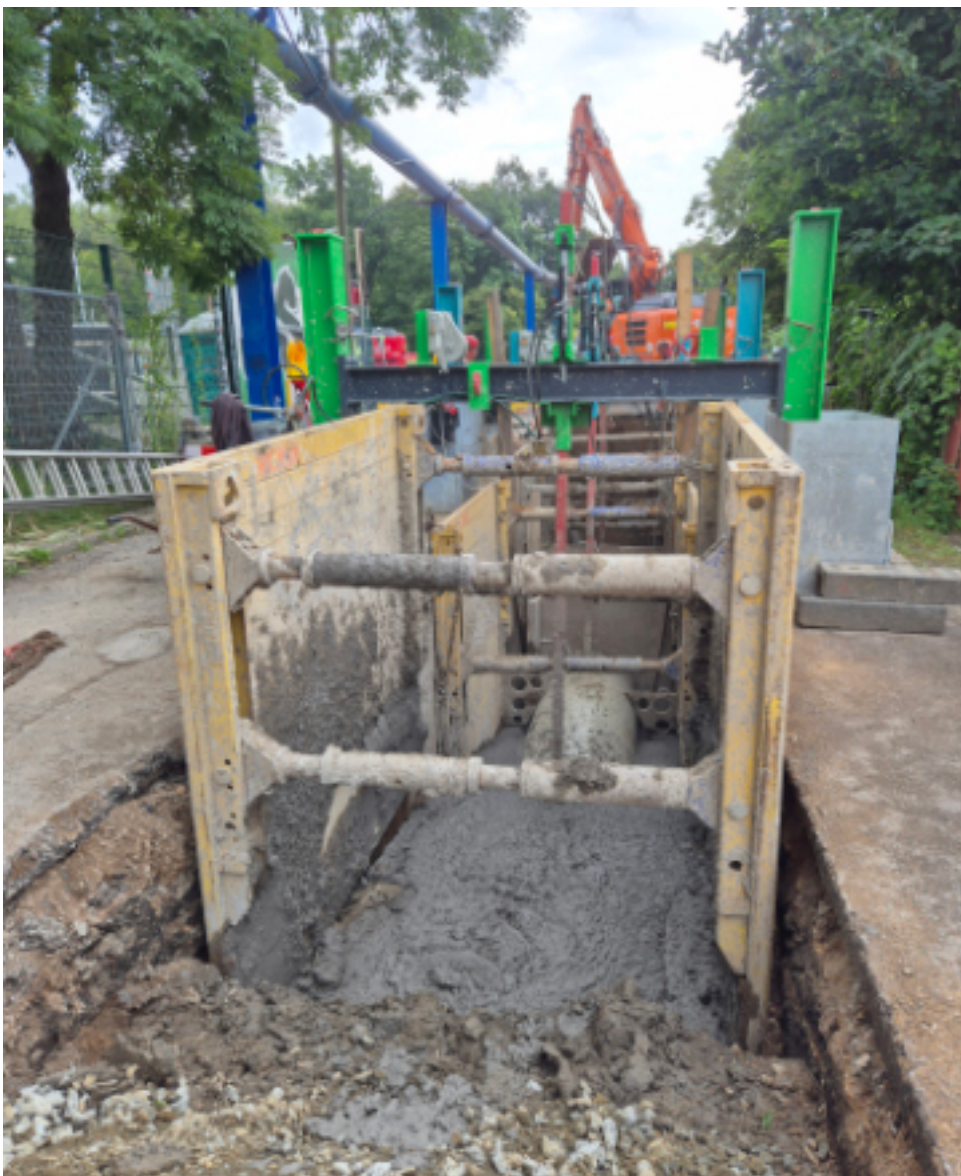
Fünf Verbauboxen und drei Rohrverlegehilfen im Einsatz. Foto: Hauser Service
