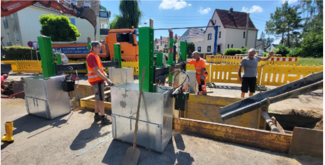
Fünf Verbauboxen und drei Rohrverlegehilfen im Einsatz. Foto: Hauser Service
