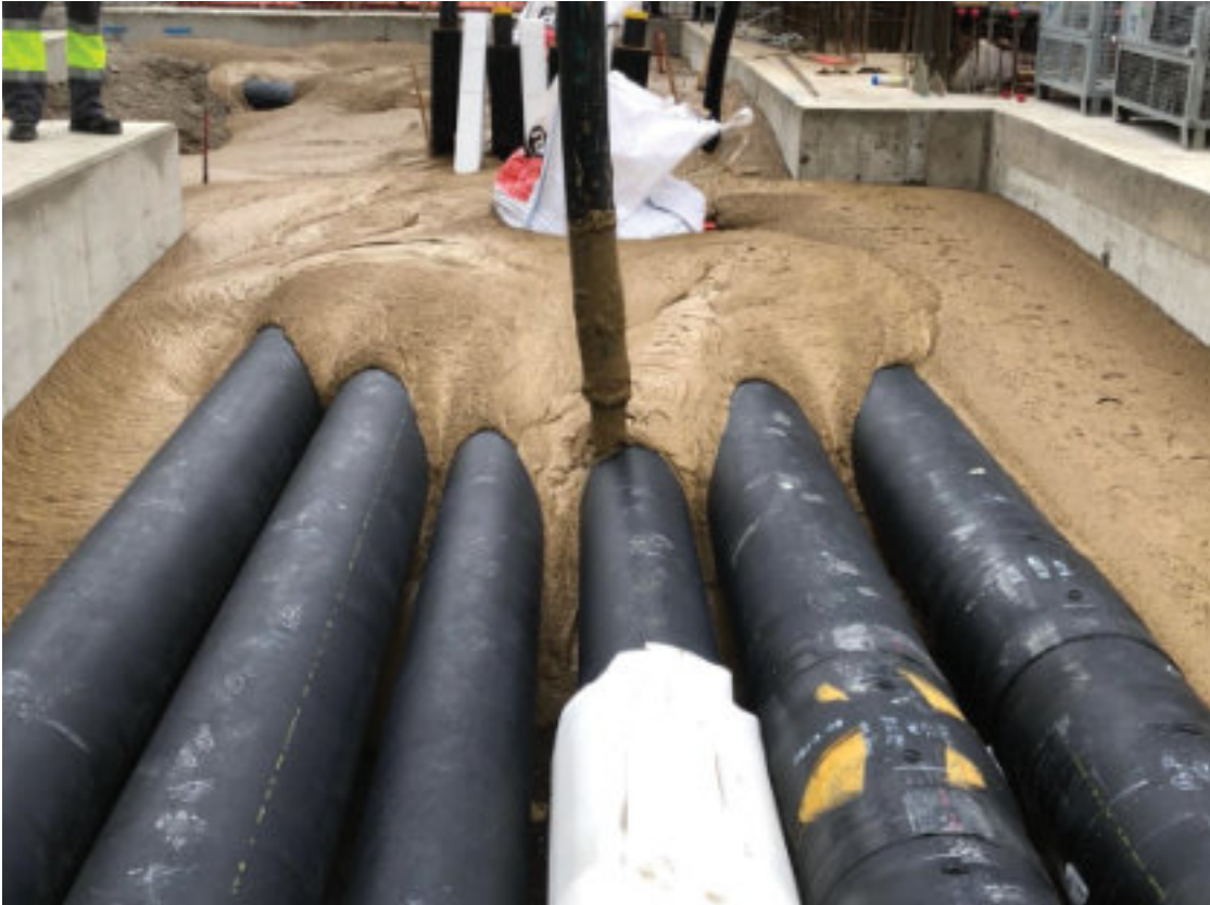
Beim Einbau des Flüssigbodens auf der Baustelle Flughafen München waren besonders logistische Herausforderungen zu meistern. Foto: Bernhard Rott GmbH & Co. KG
