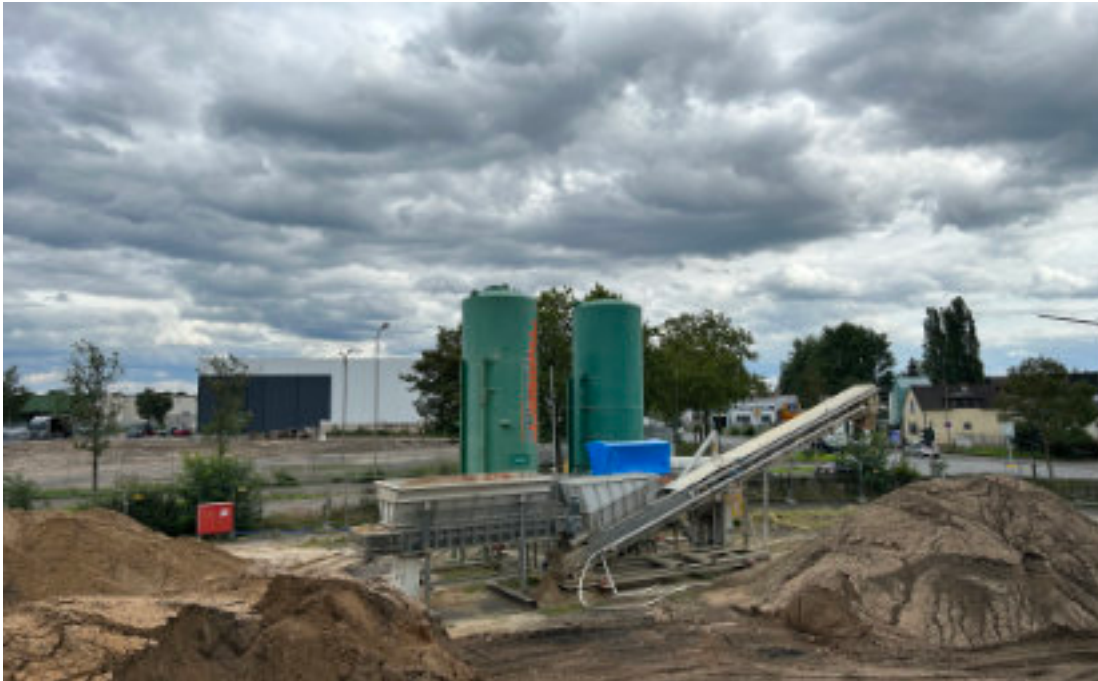
Flüssigboden-Herstellungstechnik: Hier wird z. B. in Hanau der Bauaushub zwischengelagert, separiert und in einer mobilen Kompaktanlage gemäß der vorgeschriebenen Rezeptur in Flüssigboden nach RAL-GZ 507 umgewandelt. Foto: Südwestdeutsche Rohrleitungsbau GmbH
