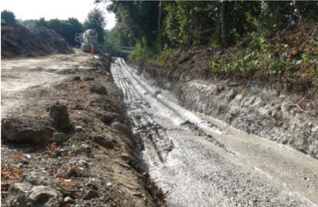
Verfüllung einer Fernwärmetrasse bei Ulm mit Flüssigboden. Der Bodenaushub wurde zuvor in der Kompaktanlage in Flüssigboden nach RAL-Gütezeichen 507 aufbereitet und zu 100% wiederverwendet. Fotos: Andreas Bechert
