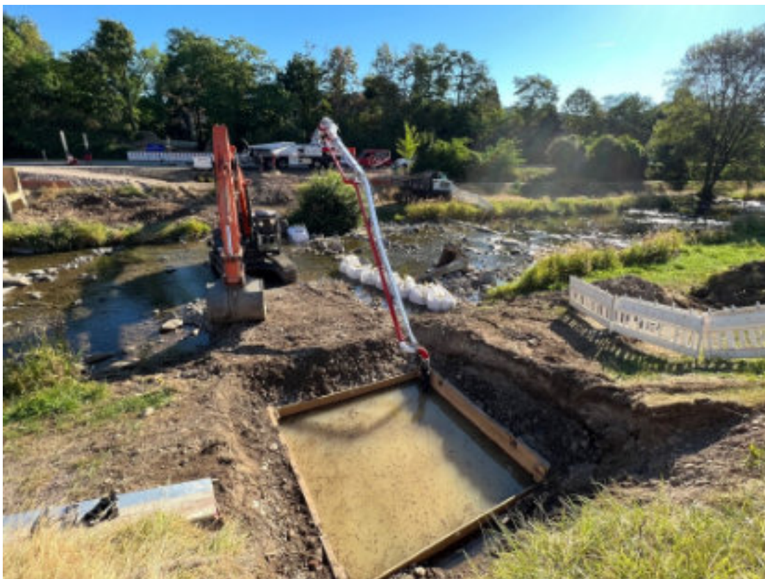
Herstellung eines Geopontons als Stützkörper (Verbauersatz) im Wasser.
