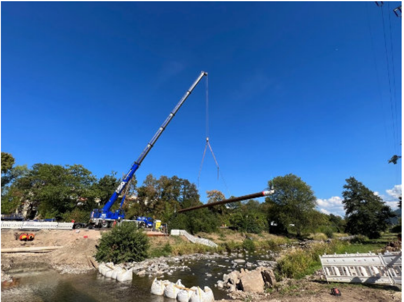
Ein Spezialkran schwenkt die vormontierten Fernwärmeleitungen über das Flussbett der Dreisam.
