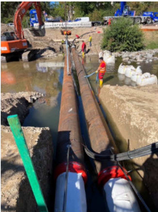
Ein Spezialkran schwenkt die vormontierten Fernwärmeleitungen über das Flussbett der Dreisam.
